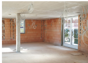
Oktober 2022 Rohbau innen
