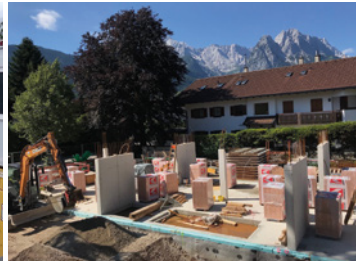
Juli 2022 Bodenplatte und erste Wände
